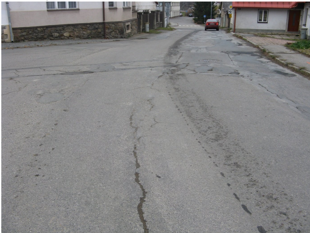
km 17,945- Mozaikové, podélné a nepravidelné rozvětvené trhliny, síťové trhliny, překop/rýha s vysprávkami, výtluky a nepravidelnými hrboly.
