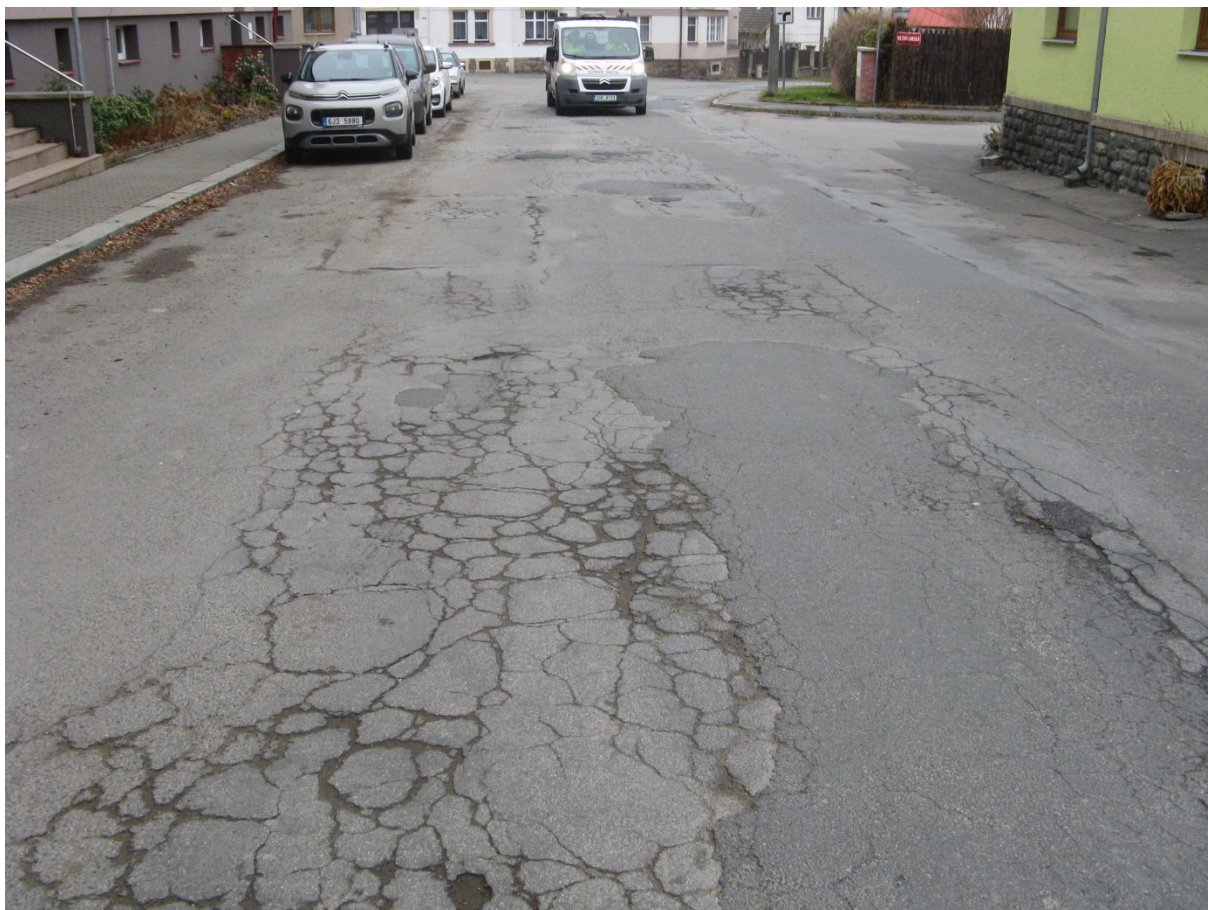
km 17,995- Síťové trhliny, plošné deformace, výtluky, vysprávky, nepravidelné hrboly.
